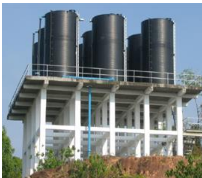
شکل (۶) نصب مخازن به صورت هوایی
