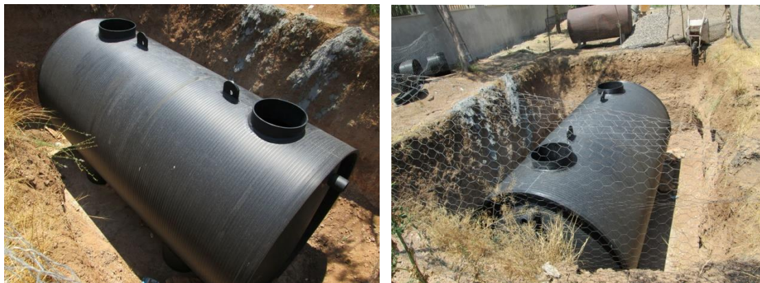
شکل (۳) جانمایی صحیح مخزن در ترانشه
