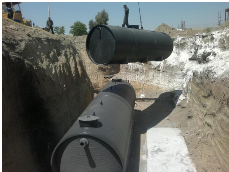
شکل (۲) جابجایی صحیح مخازن
