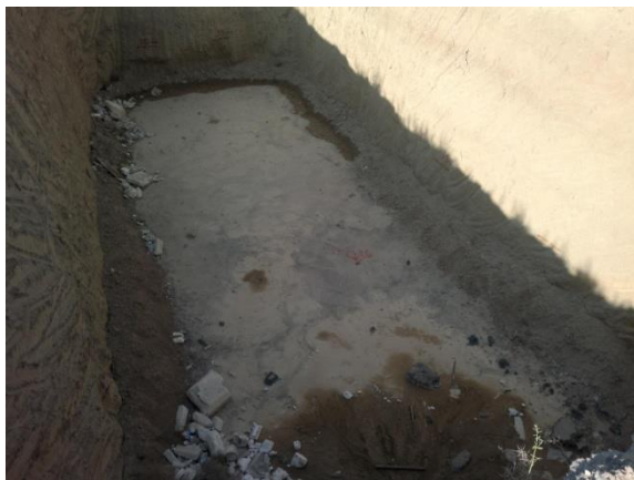
شکل (۱) خاکبرداری و اجرای بتن کف مخازن
