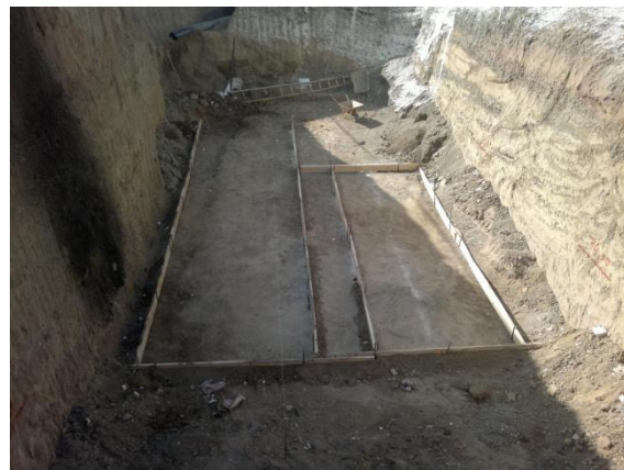
شکل (۱) خاکبرداری و اجرای بتن کف مخازن
