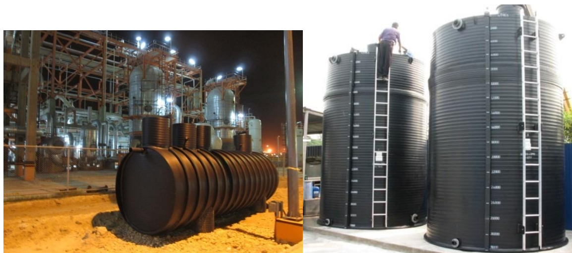
شکل (۵) نصب مخزن بر روی سطح زمین
