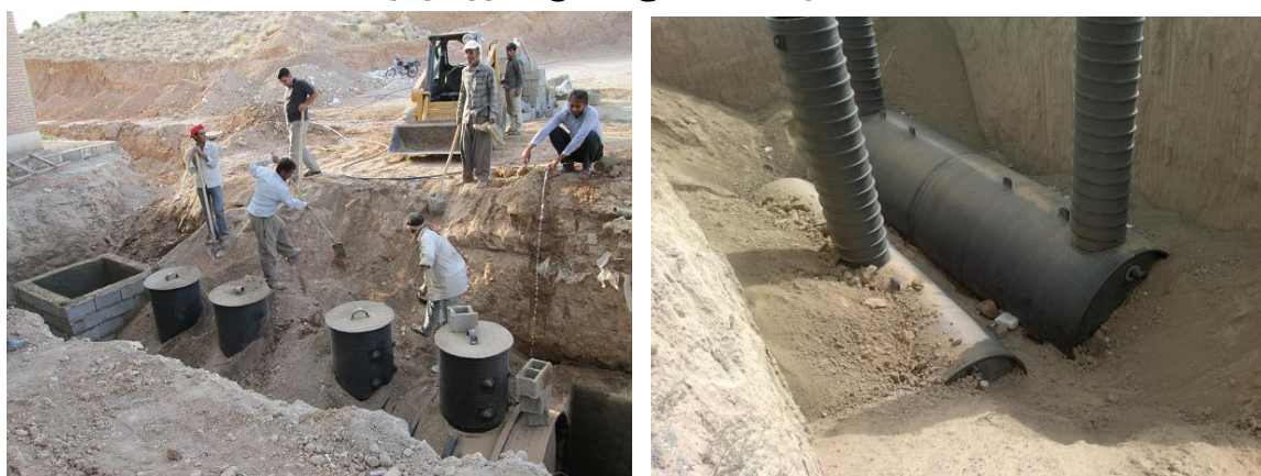
شکل (۴) پرکردن صحیح ترانشه
